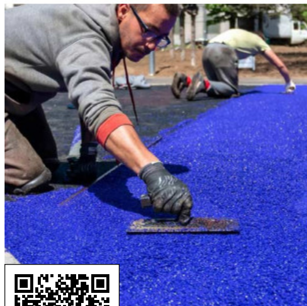
1. Sous-Couche SBR | 2. Topping de finition EPDM
